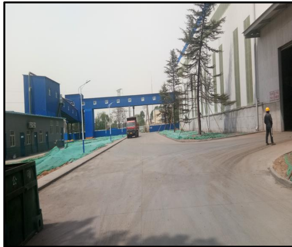
全封闭皮带输送机
